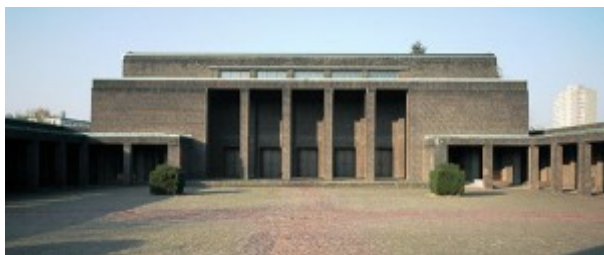
Abb. 4: Trauerhalle des Friedhofs an der Eckenheimer Landstraße von Architekt Fritz Nathan, 1929 (Foto: Knufinke).
